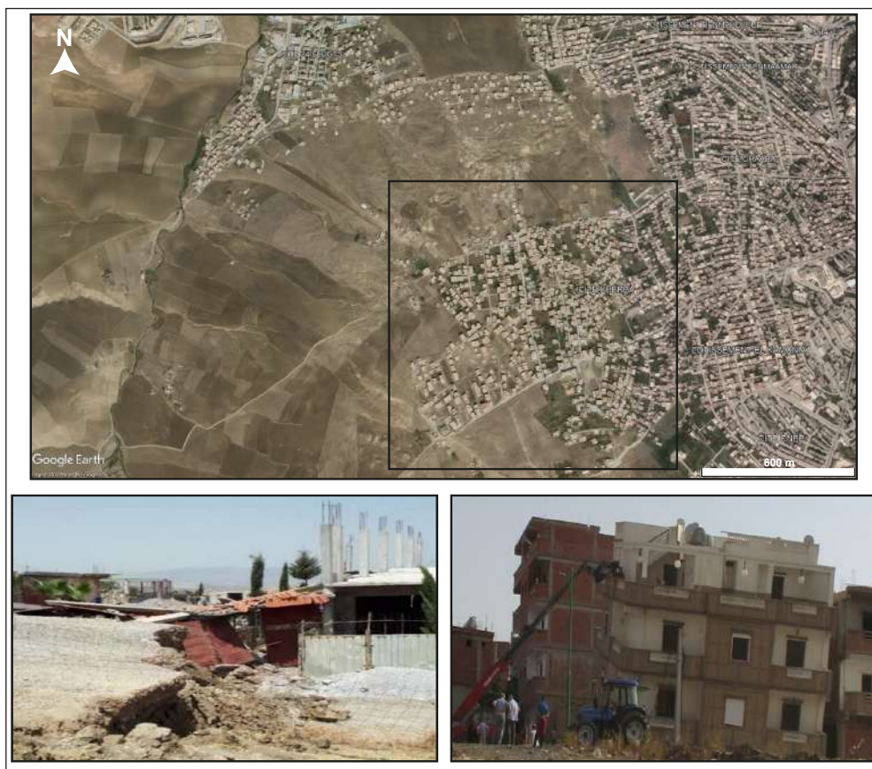
Fig. 3- Effondrement total ou partiel des habitations dans le quartier d'El Kharba. Total or partial collapse of housing in El Kharba neighbourhood.
