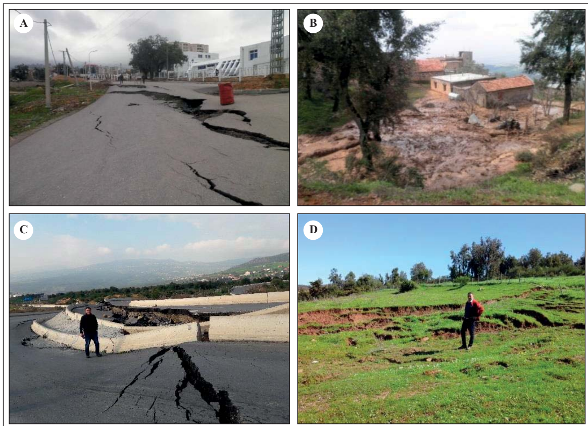
Fig. 1- Exemples de quelques mouvements gravitaires et les dommages induits suite aux fortes précipitations de l'hiver 2012 (A et B), 2014 (C) et 2018 (D) dans la ville d'Azazga.
