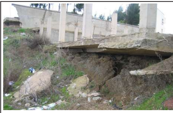
Photo 13 - Fondation dégradée d'une maison en cours de construction Collapsed house foundation
