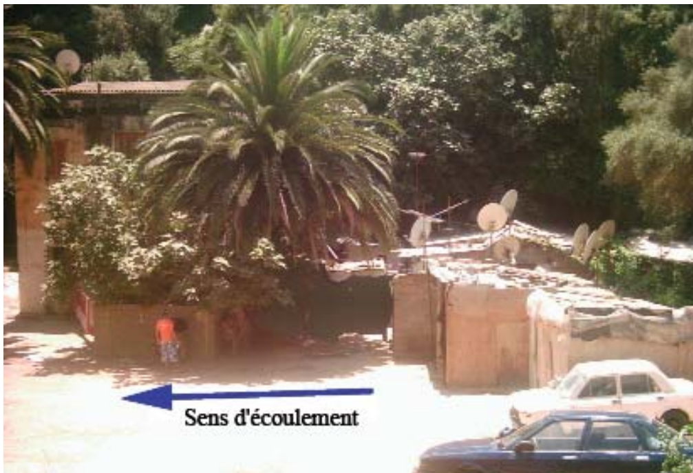
Fig. 7 - Photo montrant les constructions dans le lit mineur au niveau du Val d'Hydra (2007). Photograph showing buildings in the minor bed in Val d'Hydra (2007).
