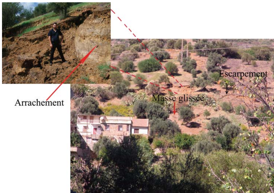
Fig. 3 - Vue générale de l'instabilité du sol
